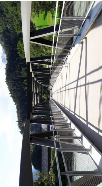
Remplissage des garde corps par filet Inox
