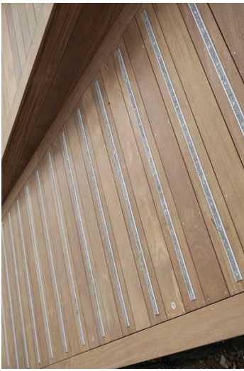
Remplissage des garde corps par filet Inox
