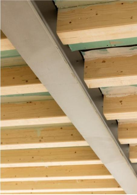
Destiné aux logements collectifs et immeubles de bureaux, le système de plancher Azurtec®/Placo® se compose du plancher CLT nervuré Azurtec®, et d'un écran thermique constitué de deux plaques de plâtre techniques (Placoplatre® BA18S Marine) prédécoupées aux dimensions souhaitées au sein du centre d'usinage et de recoupe sur-mesure de Placo®. **Une résistance au feu REI60 a été validée par appréciation de laboratoire (APL) au CSTB.**
