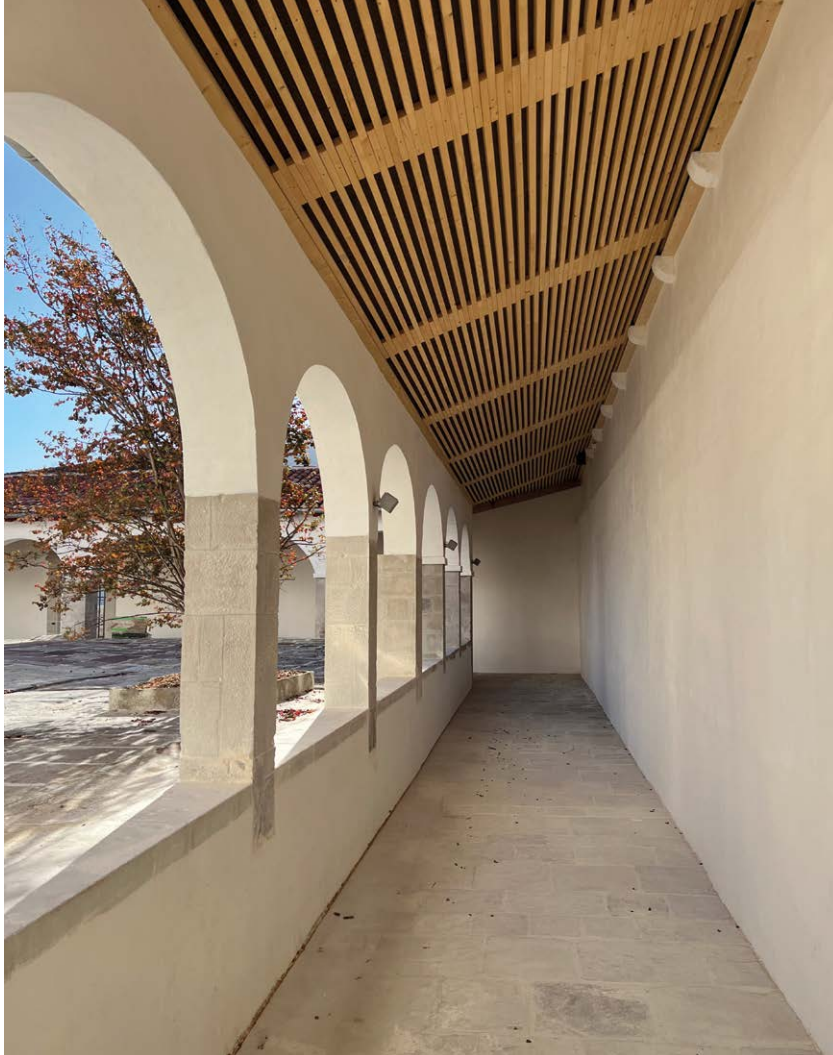
↑ Galerie du cloître après travaux.
