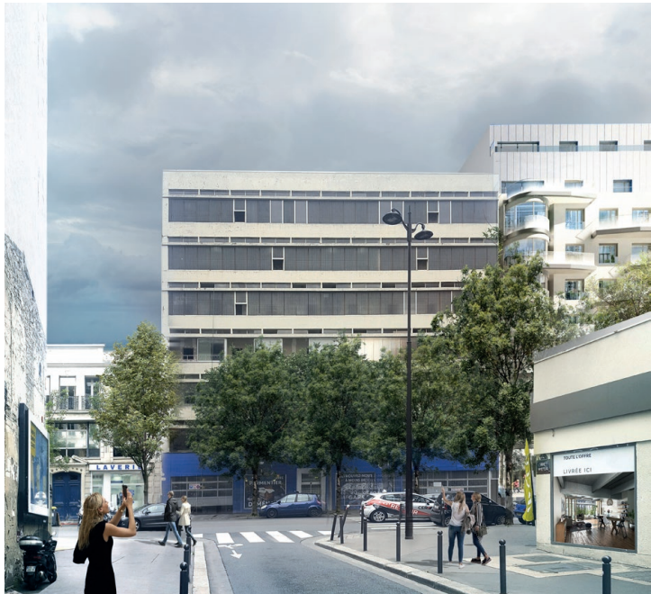
Façade avenue Parmentier - Existant
