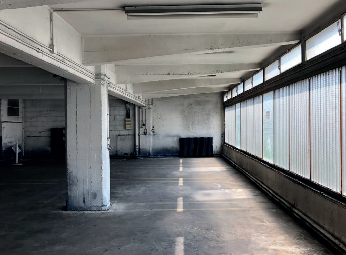
Système de poutres en consoles
