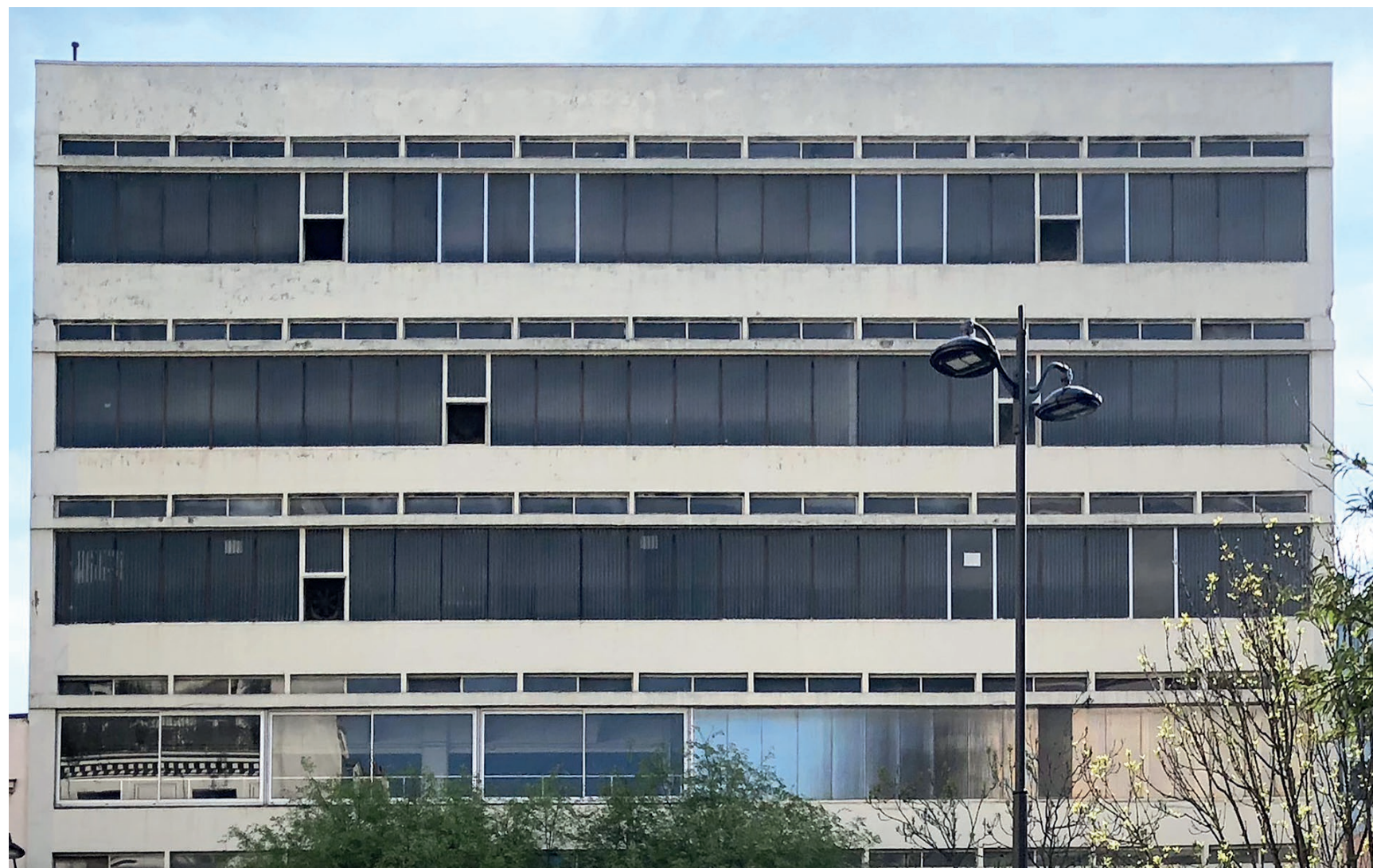
Façade bandeau - Vue depuis l'Avenue Parmentier
