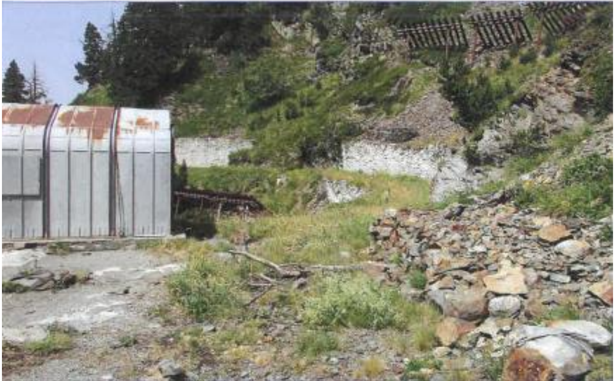
Figure 5 : Vue de la plateforme qui accueillera la drop zone (Source : AMIDEV)
