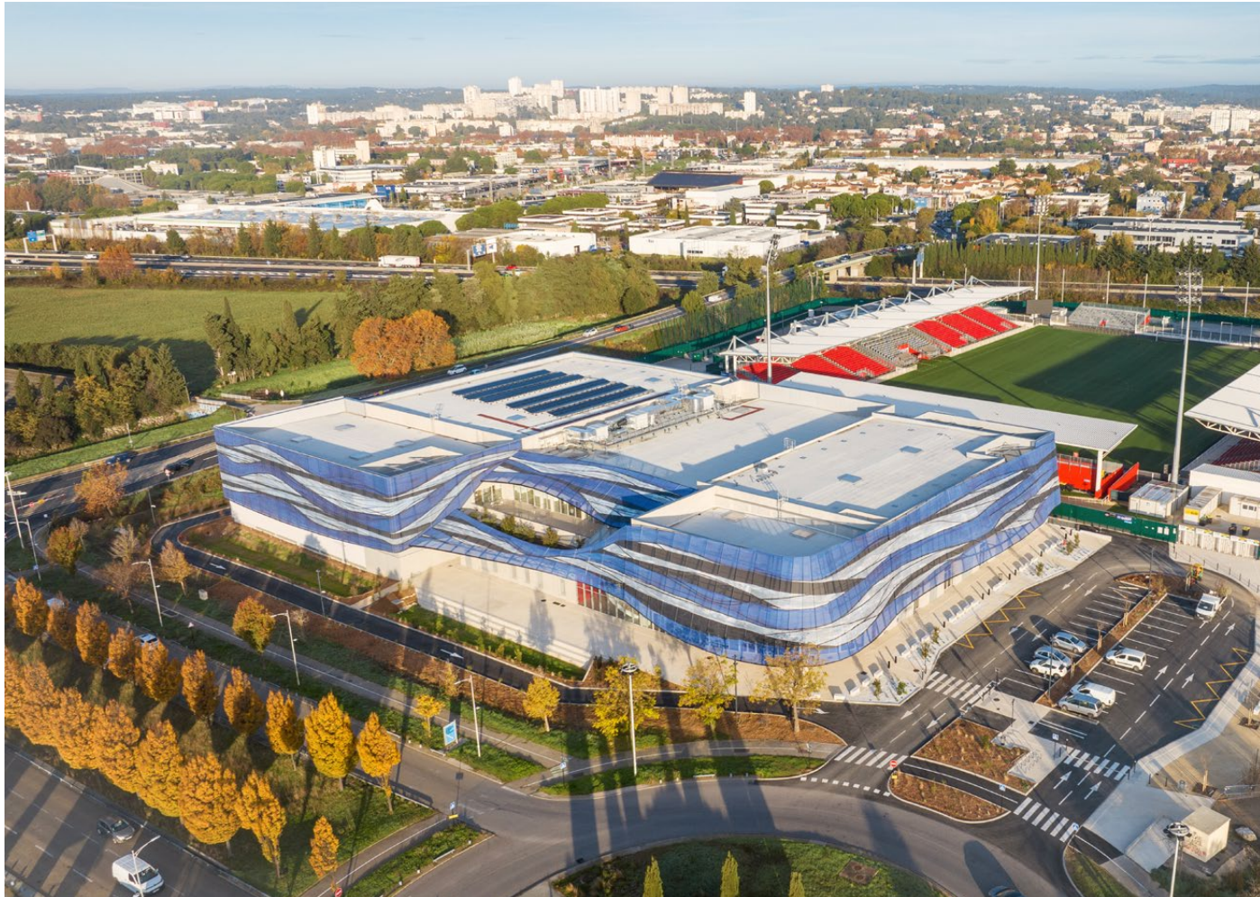
Vue aérienne depuis l'angle est
