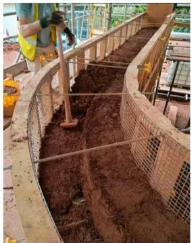
A partir d'un matériau traditionnel, la bauge, le projet CobBauge privilégie la technique du coffrage, plus adaptée aux contraintes actuelles de la construction.
