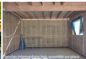
Plancher intermédiaire bois assemblé sur place.
