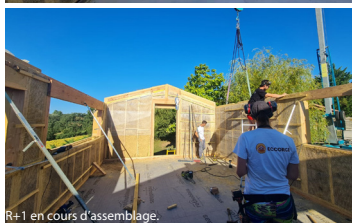
R+1 en cours d'assemblage.
