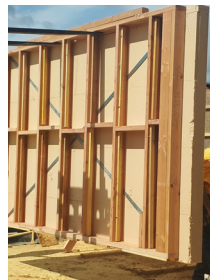
Support avant projection côté intérieur.
