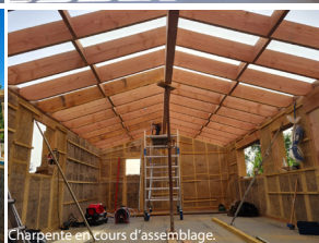
Charpente en cours d'assemblage.
