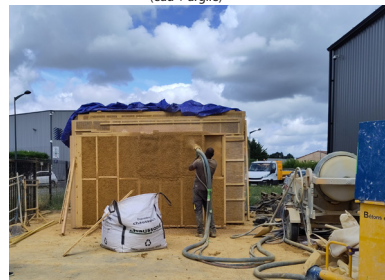
Projection du terre-chanvre : le mélange argile-chenevotte se fait en direct.
