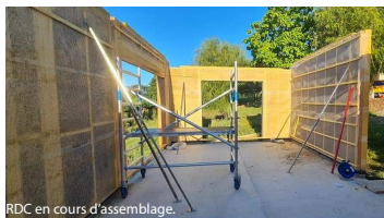
RDC en cours d'assemblage.
