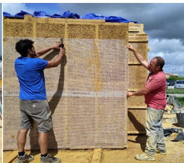
Fixation d'une trame par agrafes.
