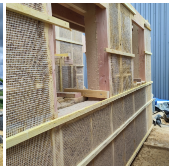
Murs en phase de séchage avant d'être transportés sur chantier.
