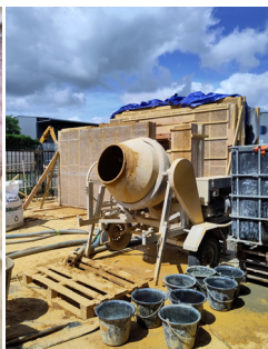
Préparation de l'argile dans la bétonnière (eau + argile)
