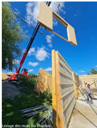
Levage des murs sur chantier.
