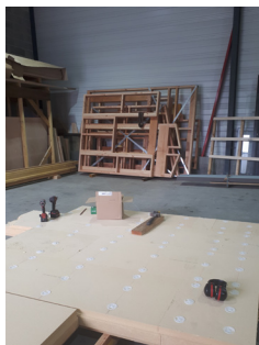
Préfabrication des murs OB en atelier (OB + ITE fibre de bois)
