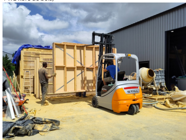
Les murs sont apportés à l'extérieur pour la projection.
