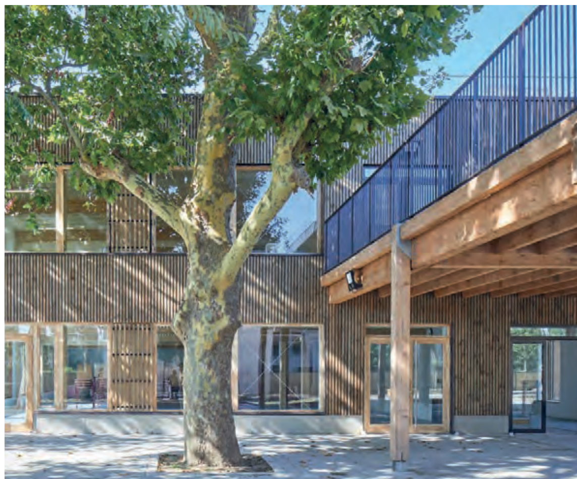
Cheminées à vent sur toitures végétalisées
