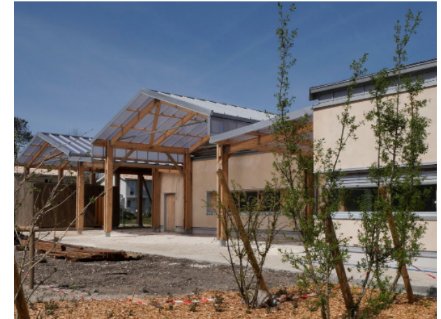
Structures des préaux en bois local et couvertures en polycarbonate
