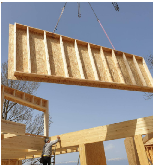
Des MOB (murs en ossature bois) en pin maritime garantissent le confort thermique des
