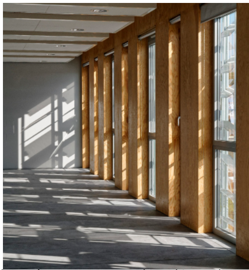
Les doublages intérieurs en panneau de bois de pin maritime déroulé sur dosse
