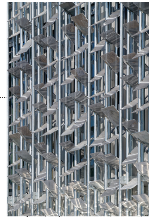
Sur façade formant un brise-soleil composé d'un tissage d'écaillés de métal et de polycarbonate recyclé avec des paillettes métalliques
