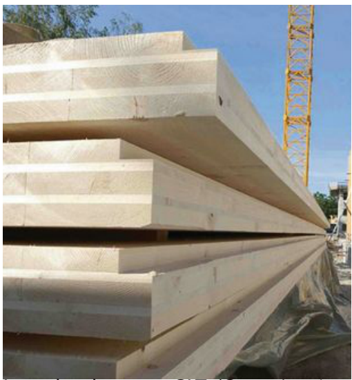
Les planchers en CLT (Cross Laminated Timber) assurent une compacité du système constructif pour contenir la hauteur du bâtiment
