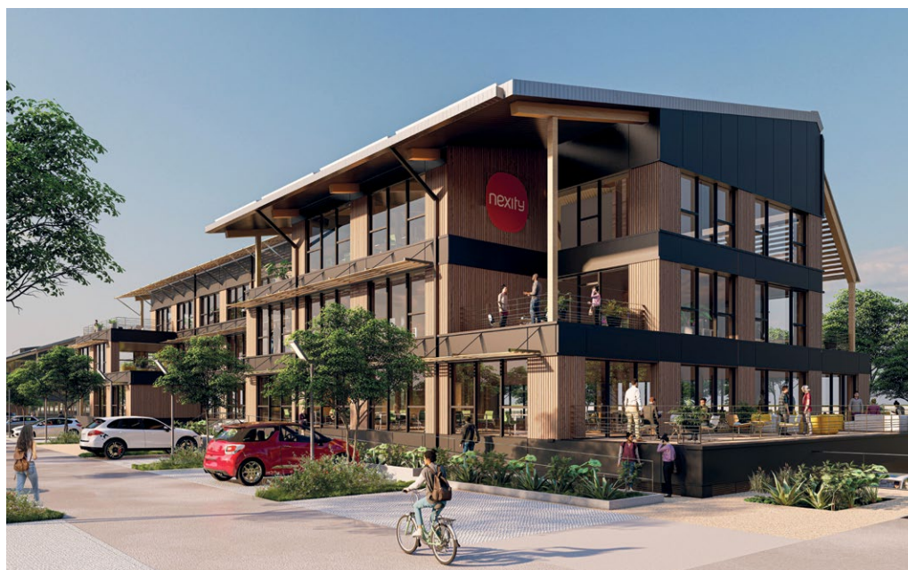
▶ L'ossature bois de New Forest confère chaleur et sérénité aux bâtiments.
