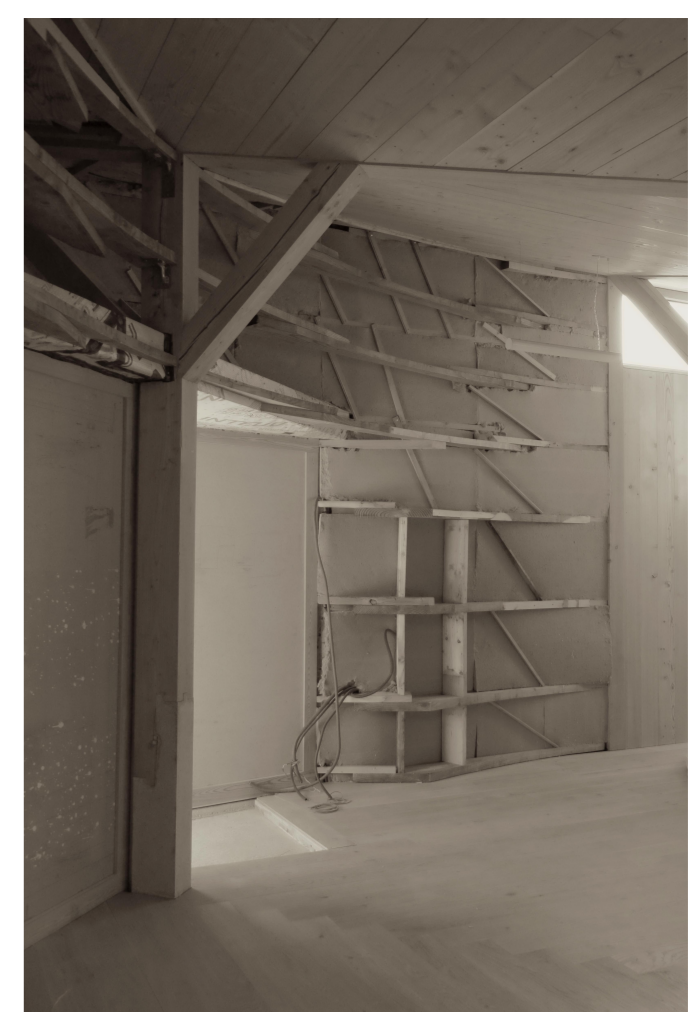
structure bois derrière la courbe © pauem atelier
