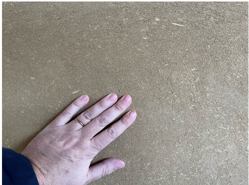
Enduit terre sur murs intérieurs
