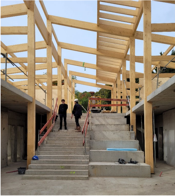
Vue de la charpente en phase chantier
