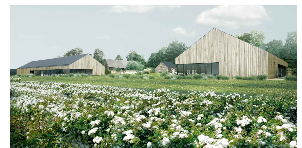
Construction de bâtiments pour une roseraie Route de Baslais - 50320 La-Haye-Pesnel
