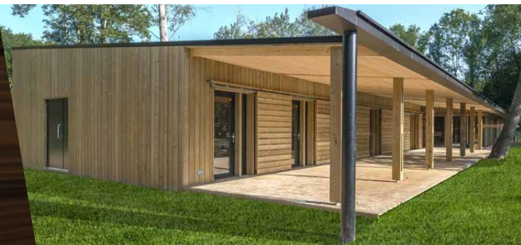
Bardage Douglas Forez - Centre archéologique à Génainville (95)
