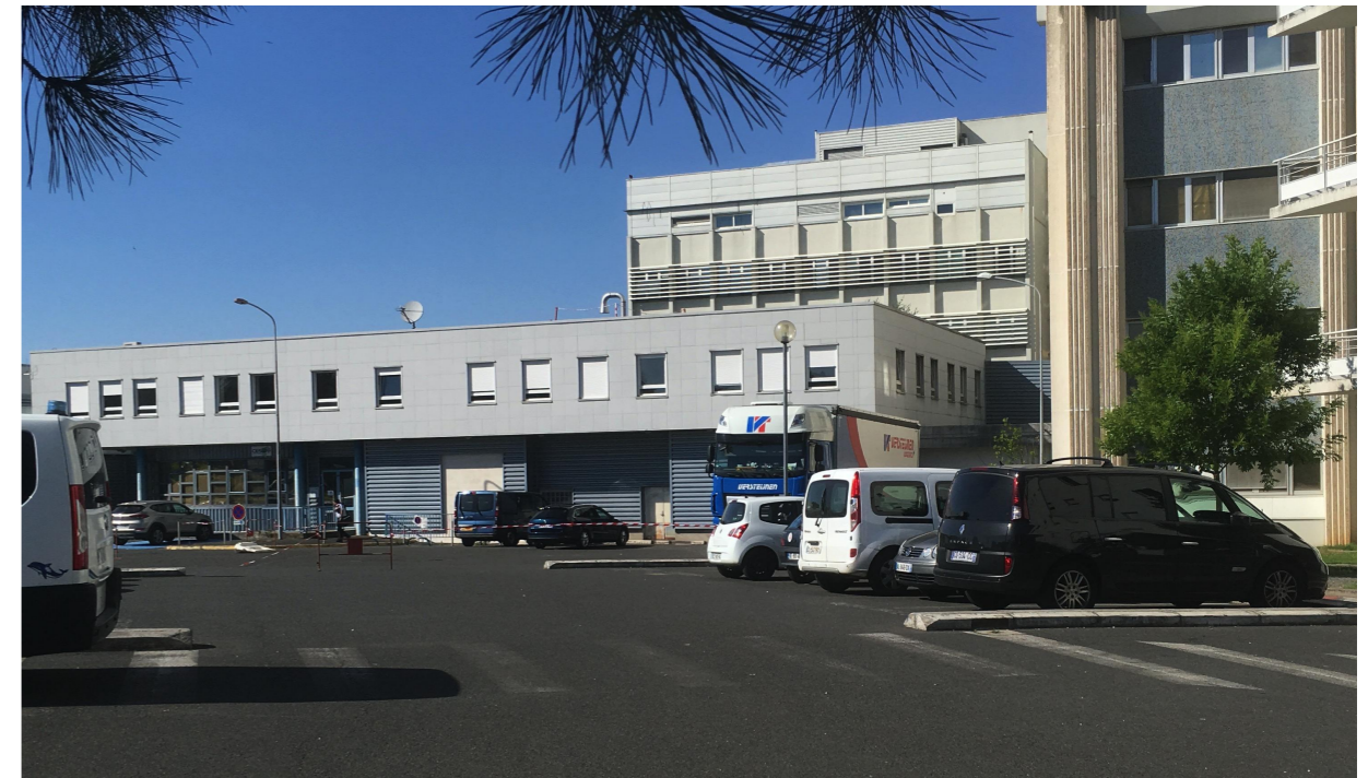
Photo du site - état existant
