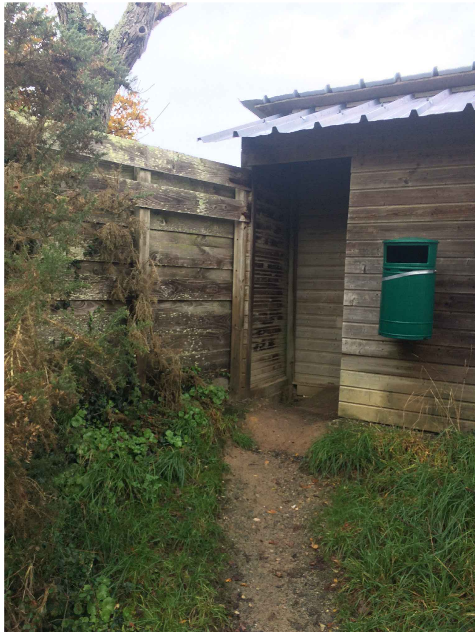
Vue proche - FACADE SUD/EST Etat existant
