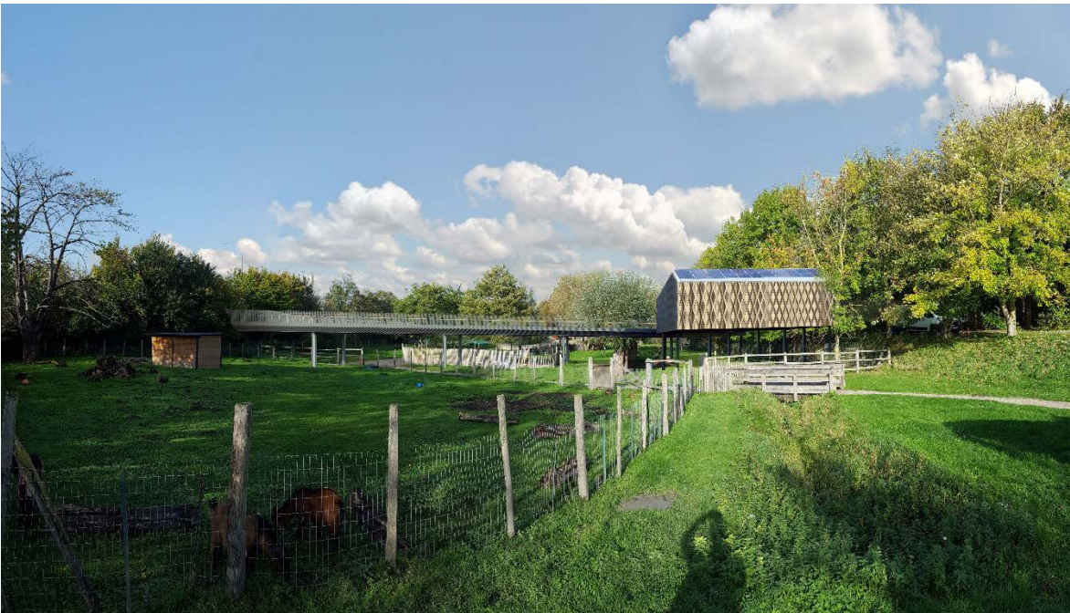
Passerelle d'entrée – trait d'union entre la ville et le parc.
