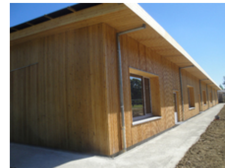
©ESAT angle façade sud-ouest
