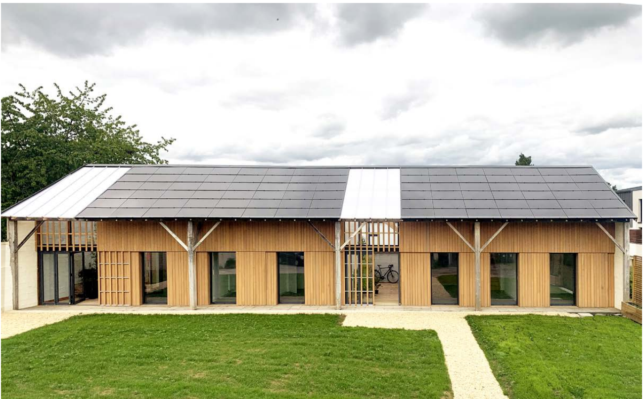
APRES - Vue extérieure sur la maison
