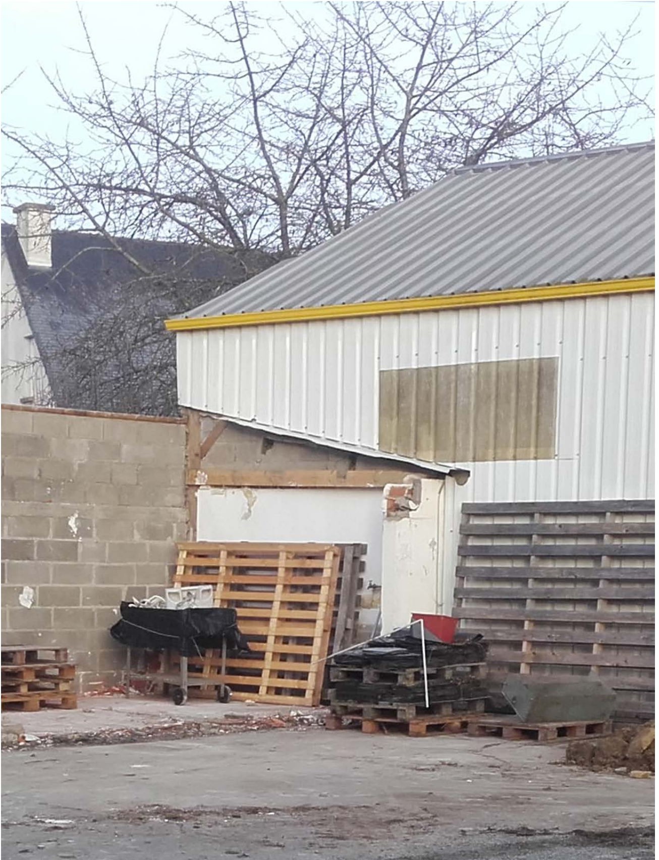
AVANT - Vue extérieure sur l'angle du hangar
