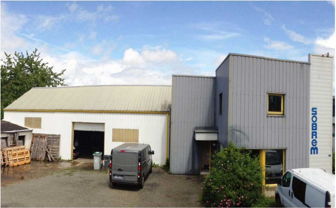
AVANT - Vue extérieure sur le hangar
