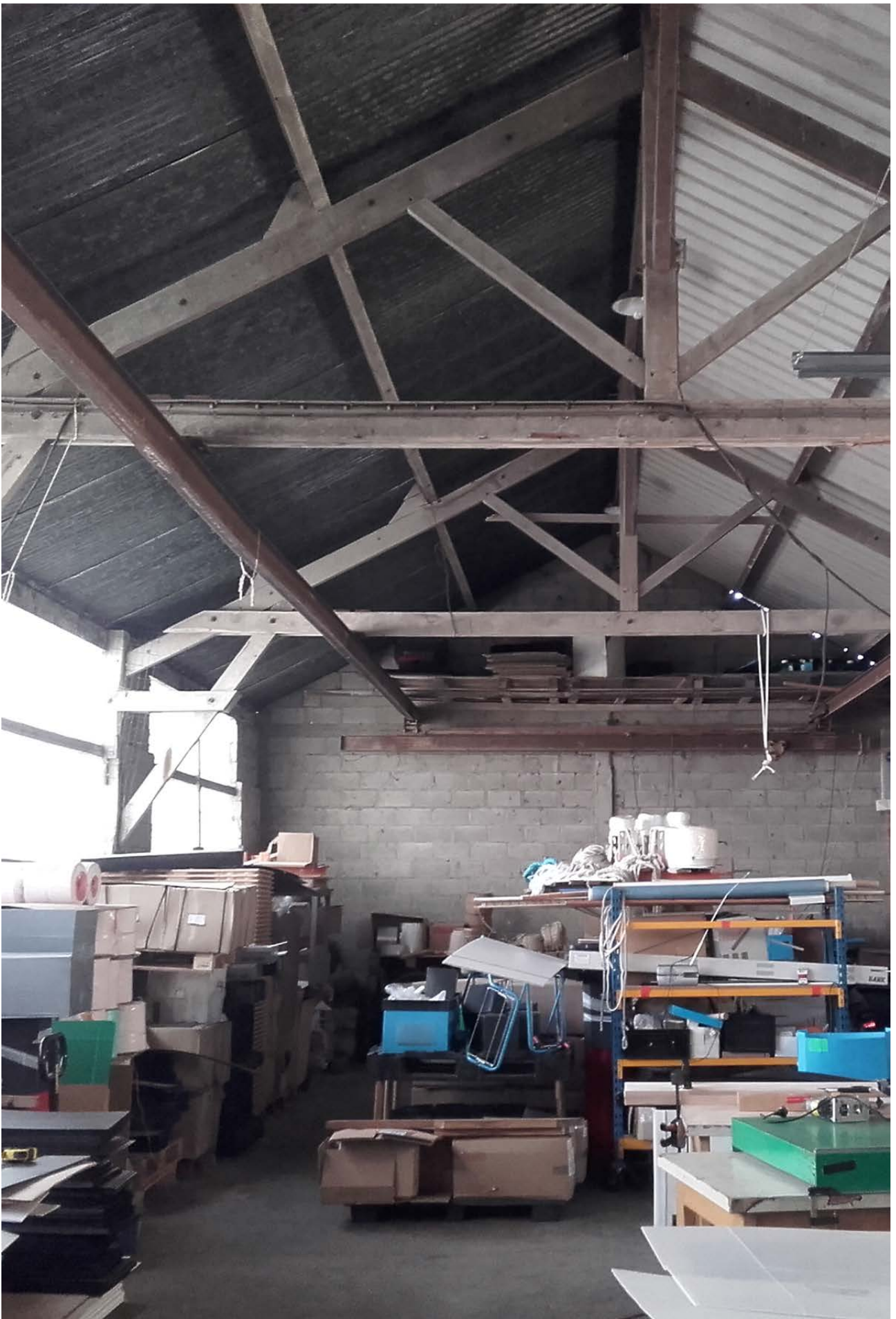
AVANT - Vue depuis l'intérieur du hangar
