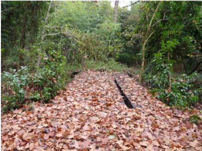
Photographie de la passerelle à démolir
