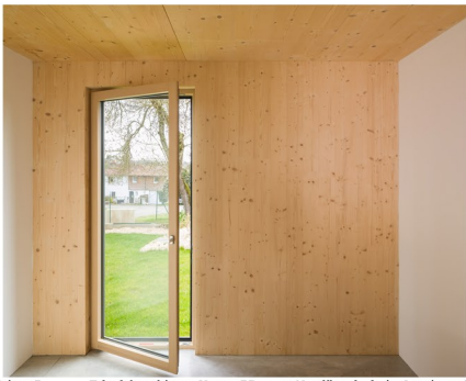
2103-Maison F -Tektolab architecte-Vertou-F.Dantart-Non libre de droits-Interieurs-2M-1.jpg2103-Maison F
