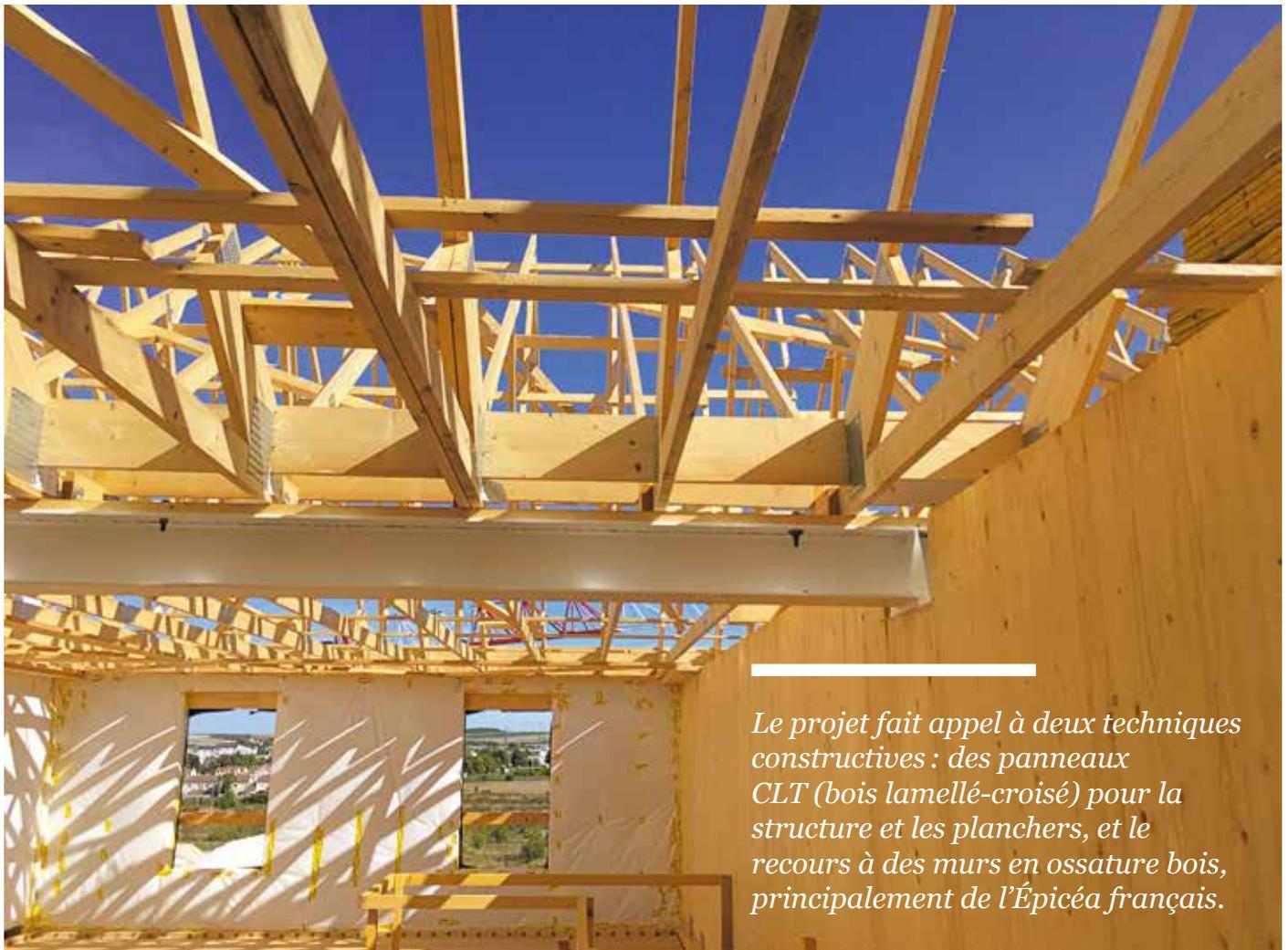
*Le projet fait appel à deux techniques constructives : des panneaux CLT (bois lamellé-croisé) pour la structure et les planchers, et le recours à des murs en ossature bois, principalement de l'Épicéa français.*
