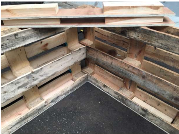
La pose du premier angle
