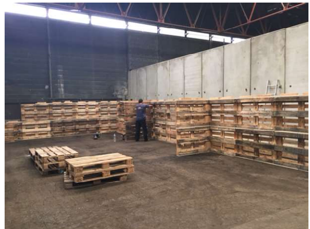
L'élévation du premier mur
