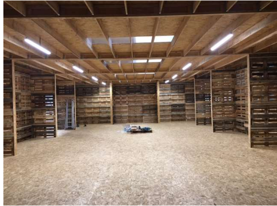
Pose de la couverture
