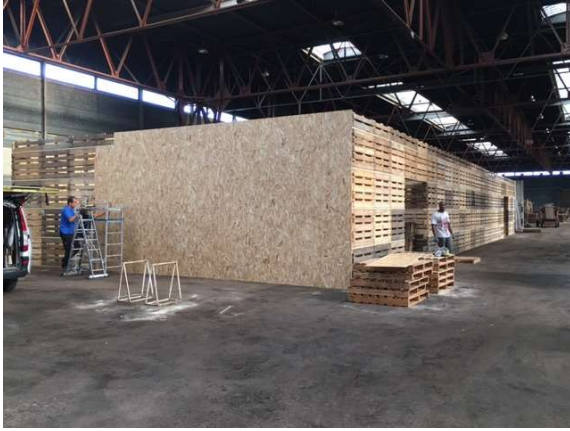
Pose du contreventement
