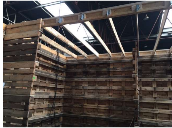
Pose de la charpente
