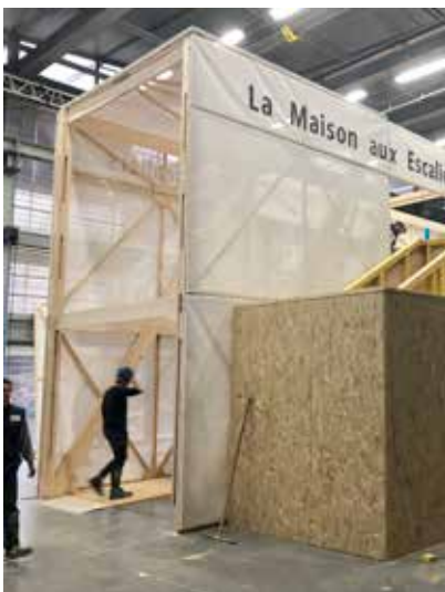
Jeudi 30 janvier 2020. 8h00/18h00 Pose et réglage des façades. Pose des marches de l'escalier balancé. Pose des garde-corps et finitions diverses. Pose des escaliers pierre. Pose de l'escalier métal.
