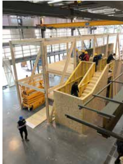
Mercredi 29 janvier 2020. 12h00/18h00 Pose et réglage de la plateforme. Pose des marches de l'escalier demi-tournant à deux volées droites.
