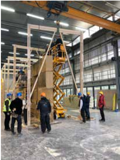
Mercredi 29 janvier 2020. 8h00/12h00 Levage des portiques de l'ossature. Pose des muralières et des rampes. Pose des murs MOB de l'escalier balancé.
