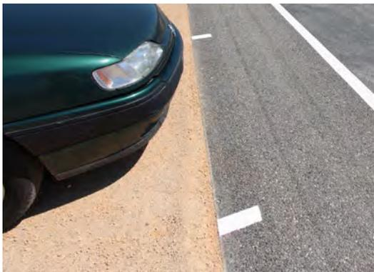
Limite entre voirie en enrobé et surface en sable stabilisé
