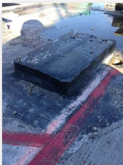
Exemple de plot étanché
