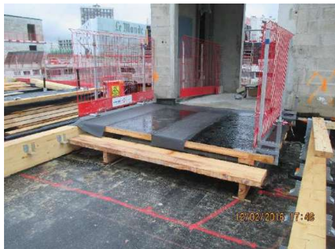
Exemple de platelage mise en œuvre au droit de sorties de réseaux
