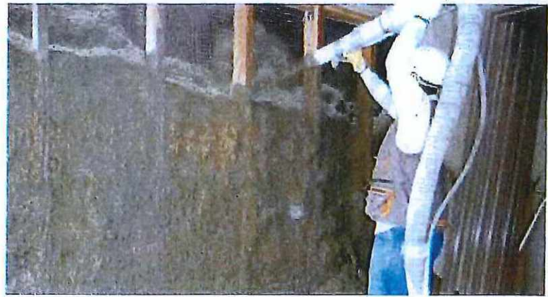
Mise en oeuvre du chanvre projeté
