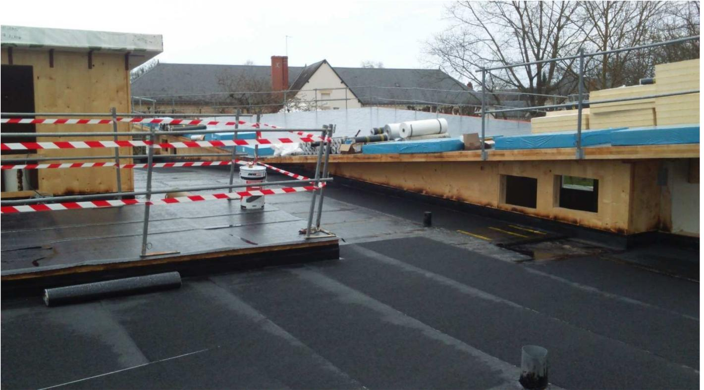
Etanchéité Bicouche et Membrane EPDM suivant zone de toiture
