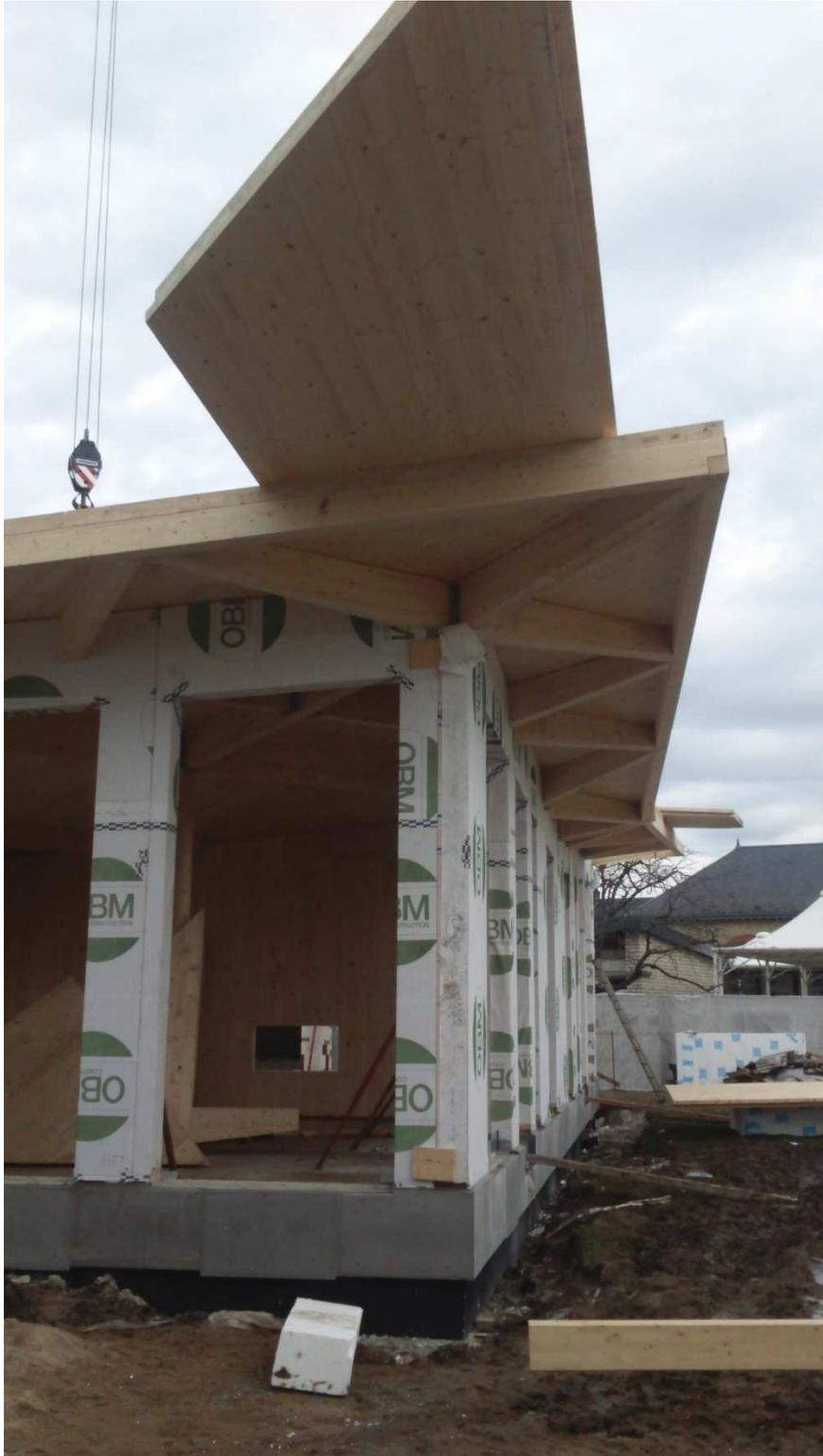
Pose Panneaux de toiture CLT
