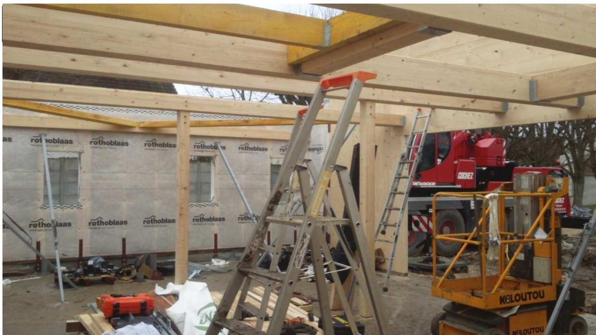
Charpente Toiture en Arbalétrier / Pannes LC - Pour support de couverture bac acier.
