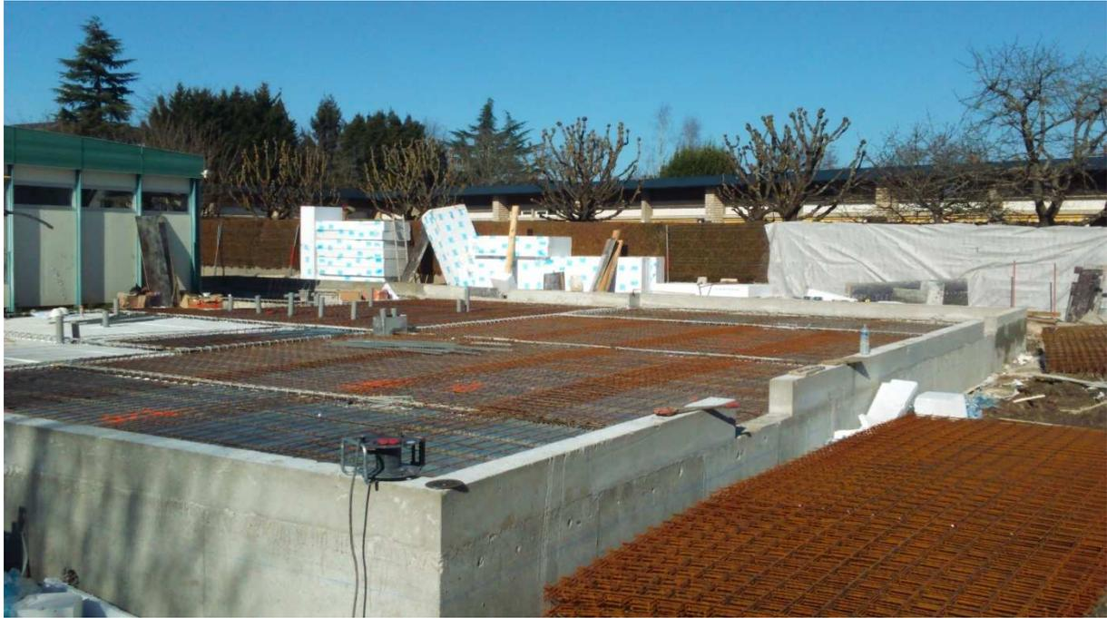
Mise en place treillis plancher – Dalle béton prêt à être coulé
