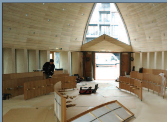
9/11/2017 : installation des bancs
