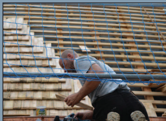
Septembre 2017 : installation des puits de lumière
