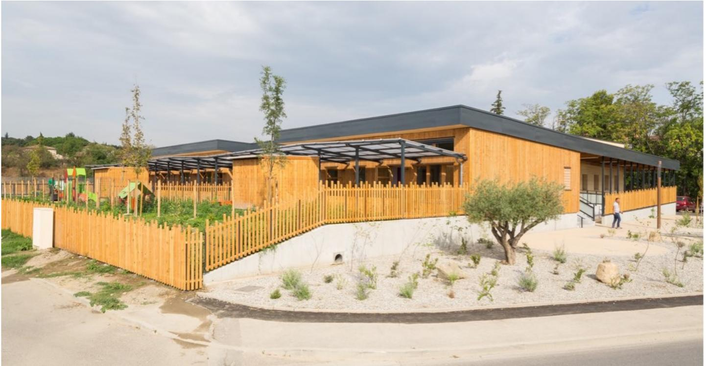
**Principaux choix Matériaux Bio-sourcés:** Structure mixte Ossature et charpente bois essence Douglas, Pierre massive de Vers, isolation murs et toitures en bottes de paille du Gard, toitures végétalisées, Bardages cèdre du Mont Ventoux, Enduits terre intérieur, peinture et mobilier sans COV, sols en linoléum, faux plafond en fibres de bois.
