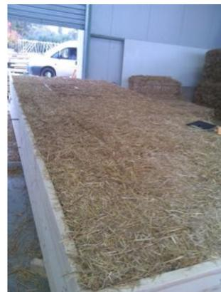
> Pose sur chantier des bottes de pailles en murs et réalisation du Gobetis.
