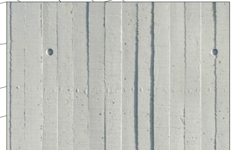
SOUS-BASSEMENT BETON BRUT DE DECOFFRAGE MATRICE VERTICALE
