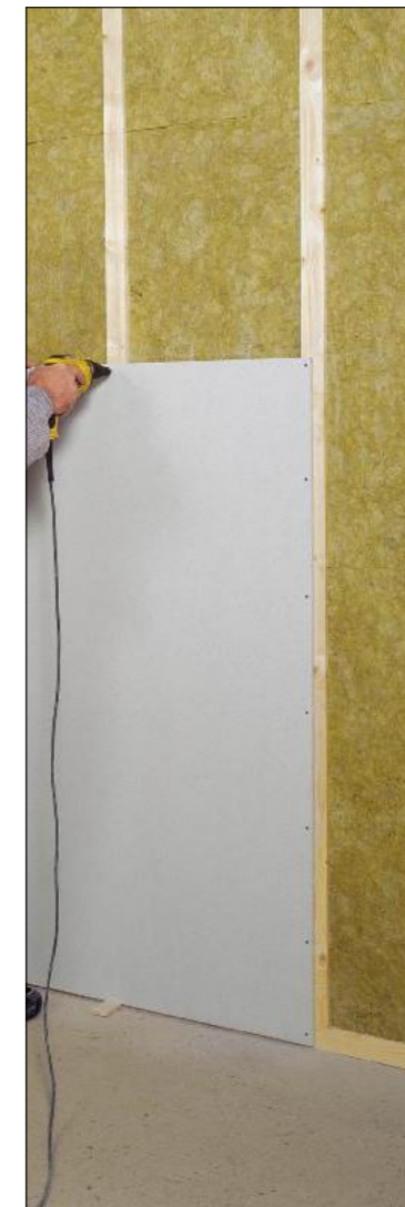
POSE PLAQUE DE PLATRE SUR OSSATURE ACIER
