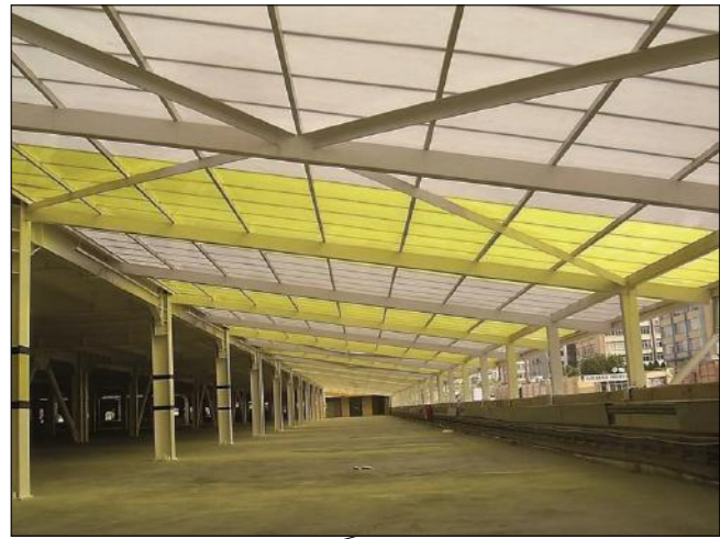
TOITURE PANNEAUX POLYCARBONATE OPALES + VOILES D'OMBRAJE
