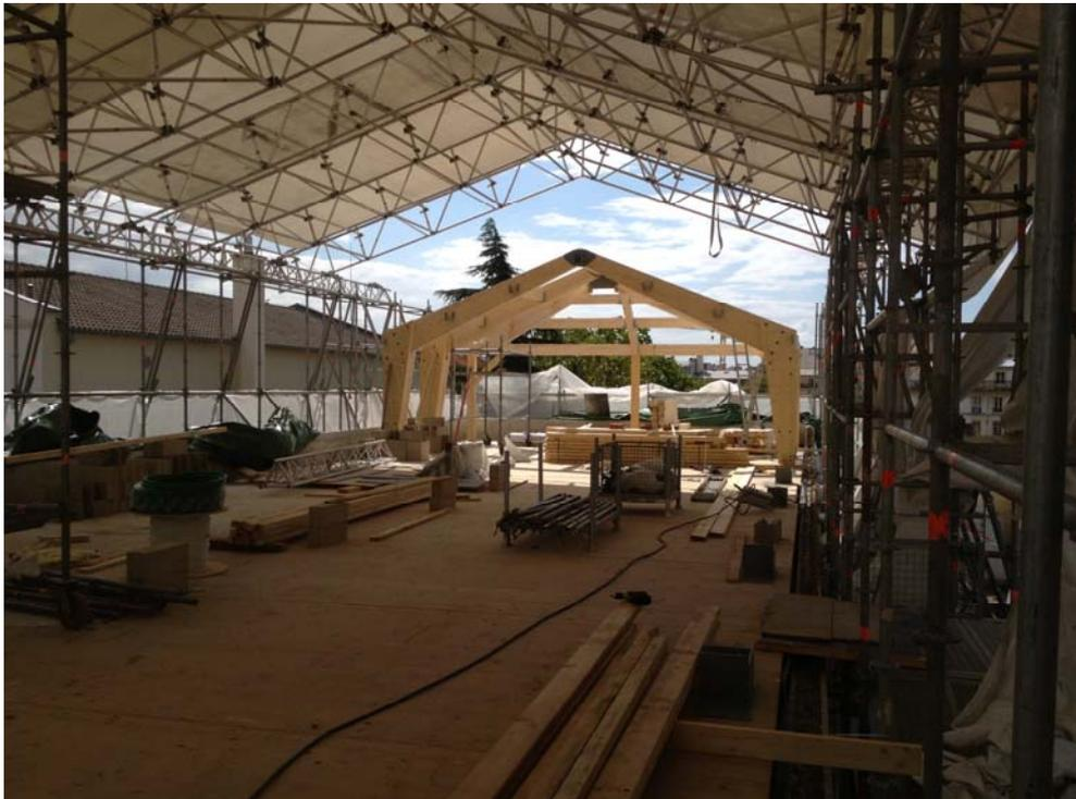
Image 17: Mise en œuvre de la charpente / © Barcque Charpentes
