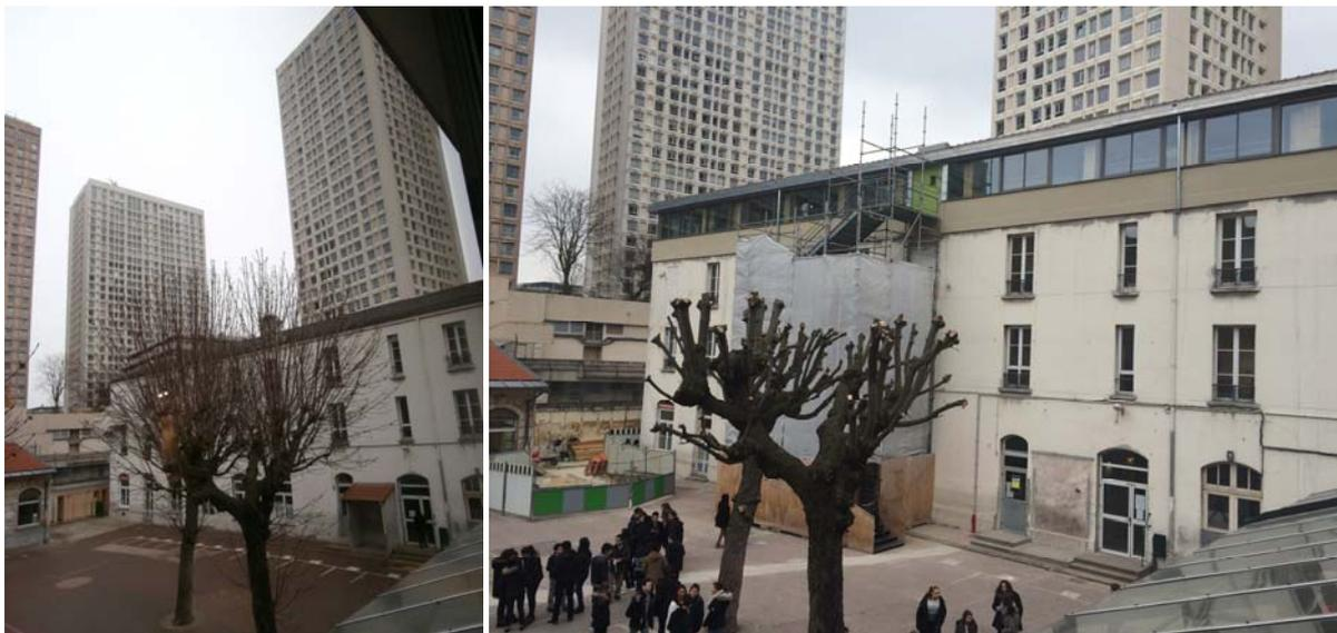
Image 5: Le bâtiment D avant travaux et après surélévation (le ravalement n'a pas encore été réalisé)
