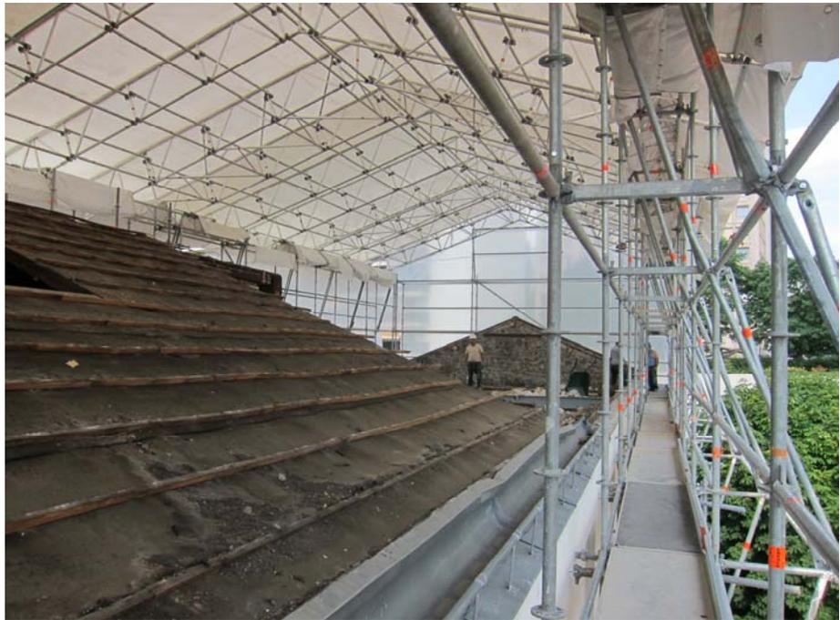
Image 7: L'échafaudage parapluie et la couverture en cours de démontage
