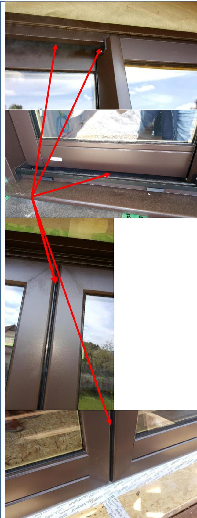
**Type :** C6-Baie coulissante: Jeu excessif entre parties vitrées d'un châssis coulissant, et/ou en partie haute et basse de châssis
