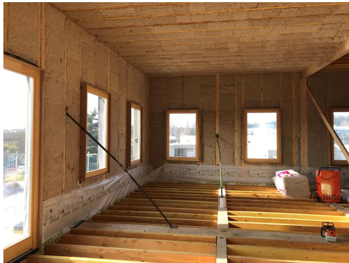
Isolants biosourcés :190mm Chanvre Trio de Biofib)+ frein vapeur Menuiseries extérieures: fabrication locale (Loire) avec allège basse
