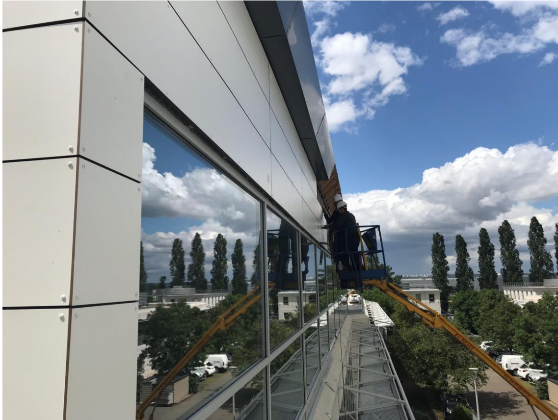
Mur rideau Est, Bardage contribuant au déphasage thermique
