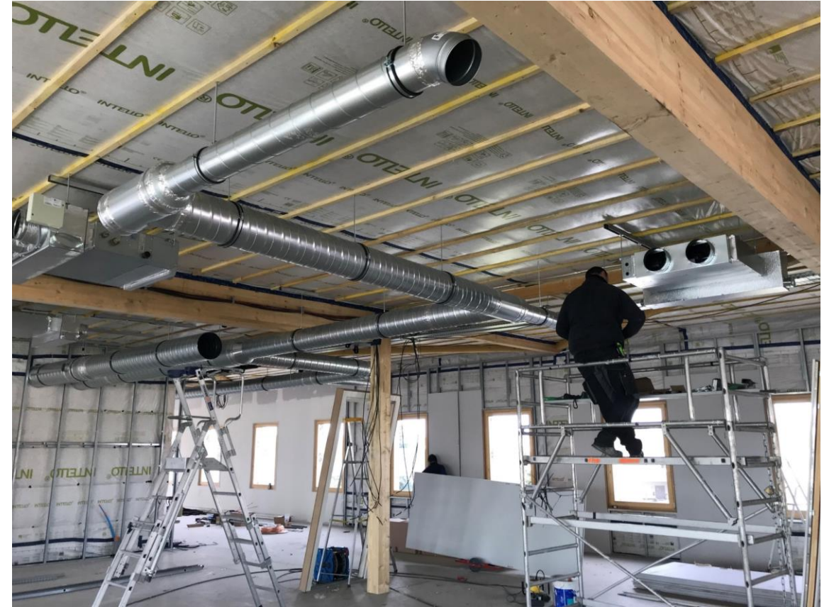
Fenêtres battantes à L'Ouest et mur rideau à l'EST , Double flux couplé au rafraichissement ( réduction des équipements )
