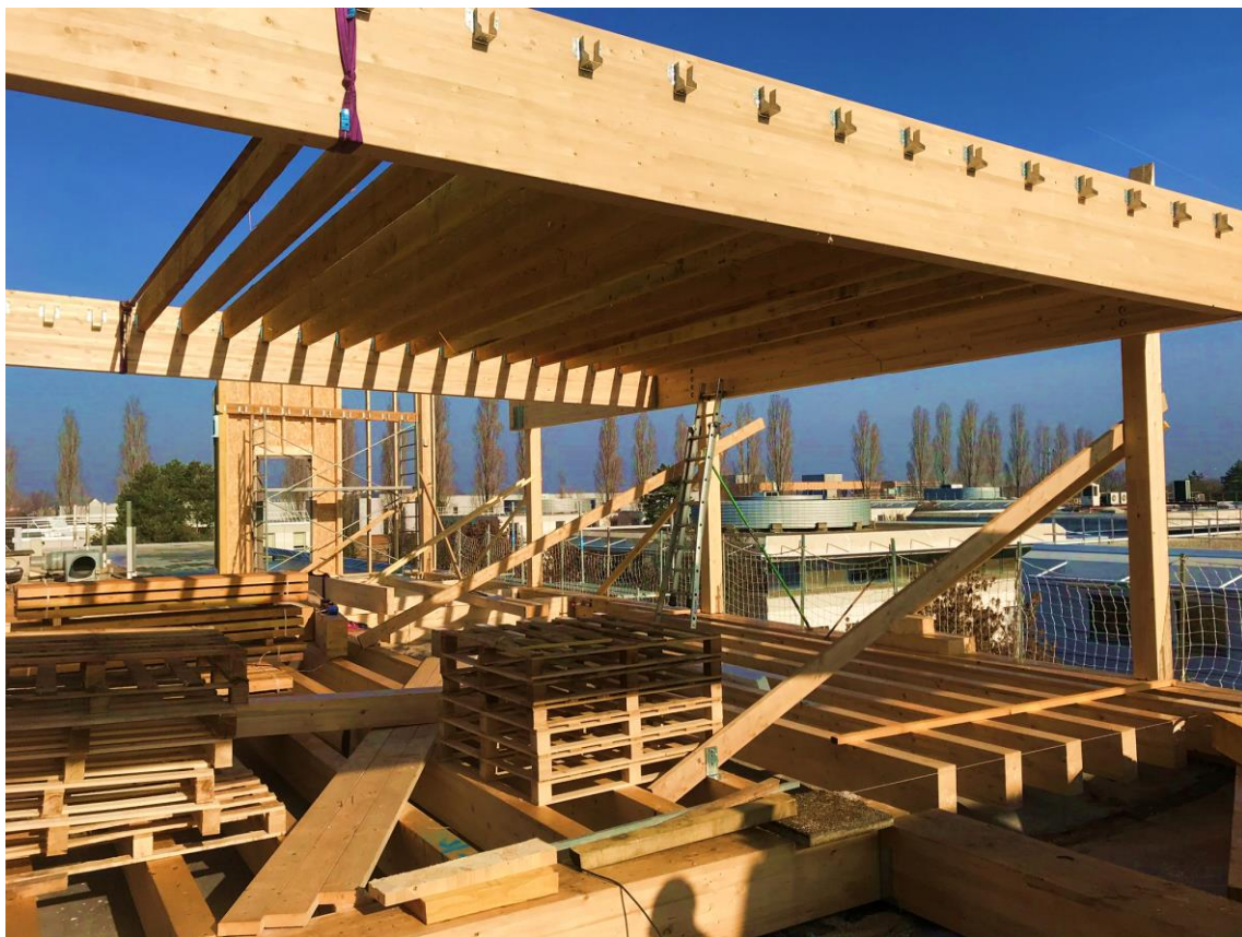
Plateforme porteuse bois (bois massifs locaux , Marque « Bois d'ici »)
