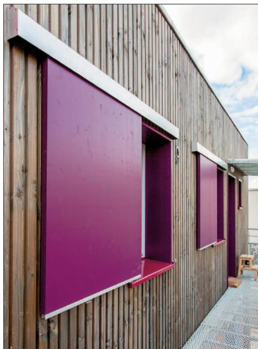
Les menuiseries bois double vitrage apportent une déperdition énergétique  $U_w = 1,2$  et un classement bruit BR1/Catégorie CE1. Les chambres sont équipées de volets coulissants bois et les baies des pièces à vivre de brise-soleil orientables aluminium Griesser.
