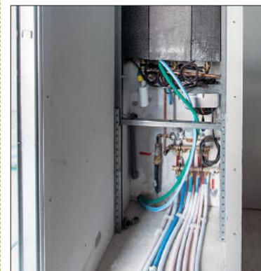
Installé au-dessus du bâti-support du WC suspendu, le système Twido (ici le modèle T3-51 W) produit une eau chaude instantanée. Il utilise une énergie hybride (électrique, PV) et se pilote via l'application smartphone MyTwido. ■
