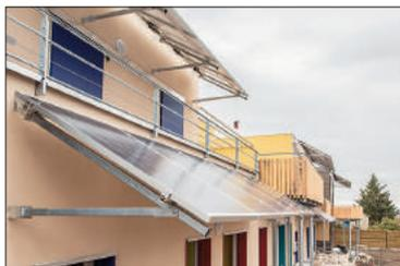
La production locale d'électricité est assurée par 96 m<sup>2</sup> de casquettes solaires photovoltaïques (15,9 kwc, 16 000 kW/an) injectée sur le compteur des communs et le réseau. L'autoconsommation est optimisée à travers le branchement direct des dix chauffe-eau Twido, de la buanderie, des ateliers. Un calcul des ombres autoportées garantit selon les saisons l'ensoleillement ou la protection solaire des baies. ■
