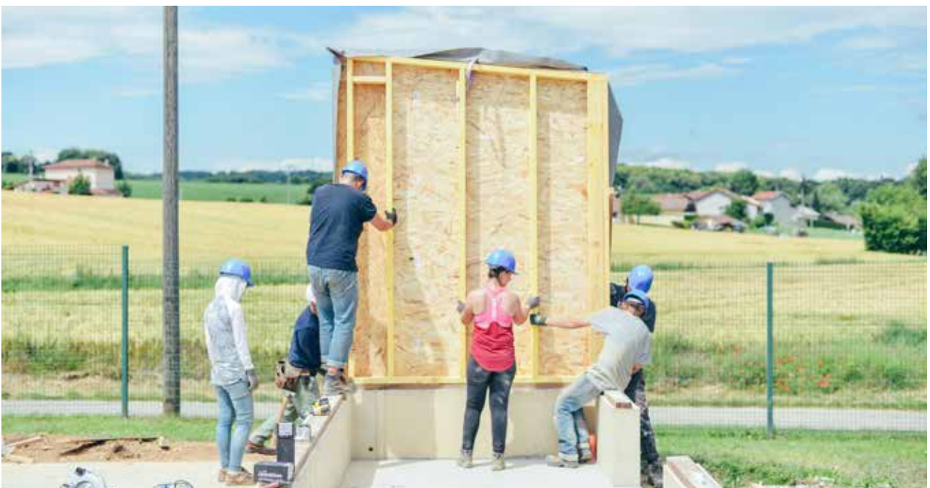
Image 20, Etudiants installant l'ossature préfabriquée du stockage
