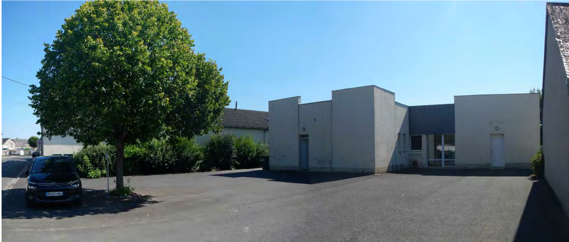
Vue 06 - Vue depuis le parking rue de Mouliherne vers le Sud - Volume cuisine
