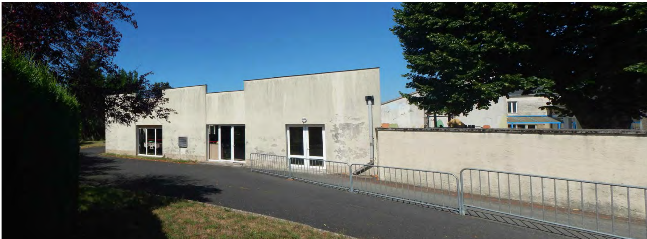
Vue 07 - Vue la parcelle sur l'élévation Sud-ouest - Accès actuel du bâtiment
