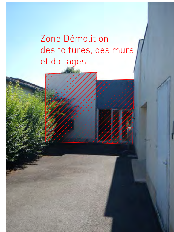
Vue 04 - Vue depuis la parcelle vers le Sud-ouest
