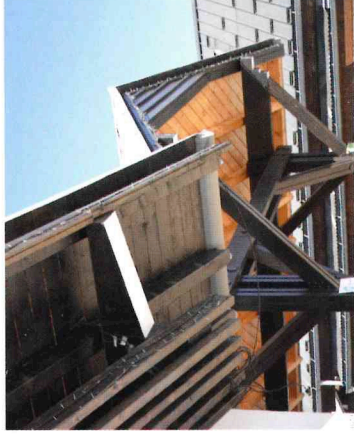
Fig. 4. Détail des rives des pignons de l'E.S.F. et de la grenette.
