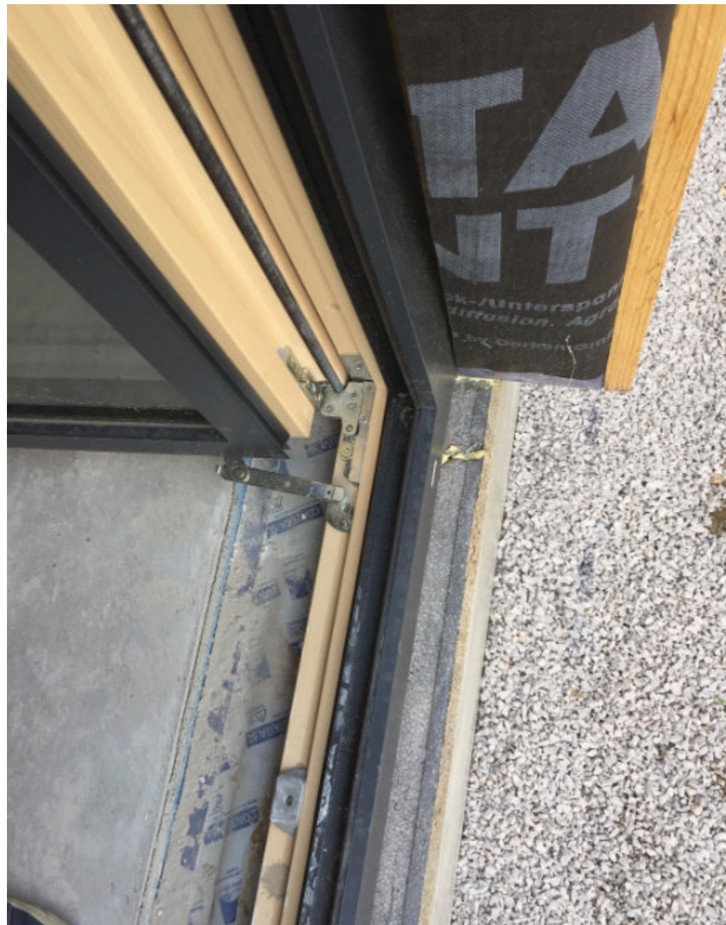
Isolation périphérique: Isolant PSE 105mm
