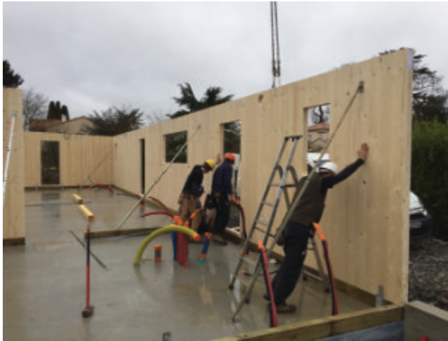
Levage par ois CLT
