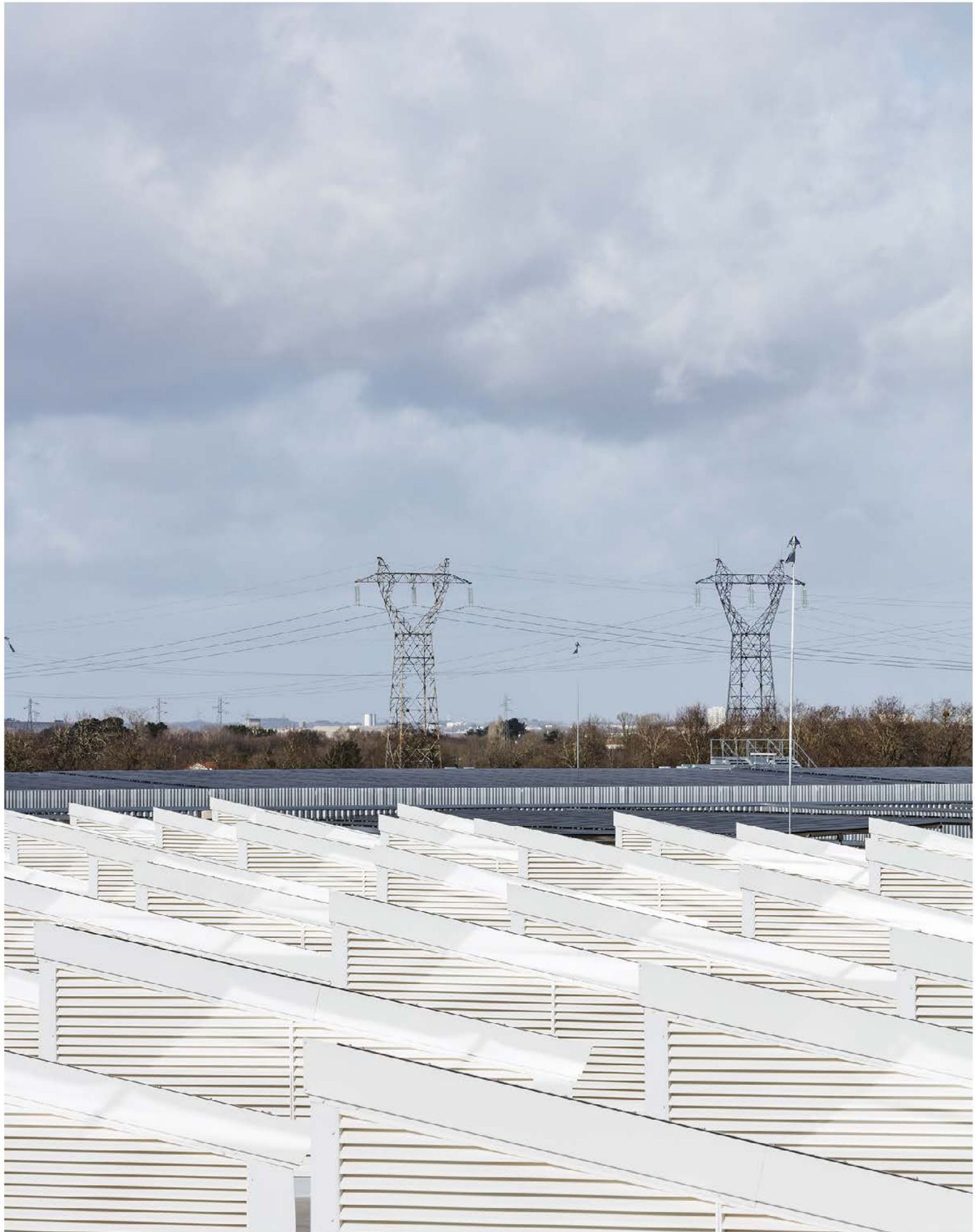
Puits de lumière équipés de ventelles pour la ventilation
